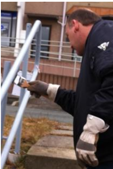
Reparaturarbeiten Geländer, Trödelmarkt
