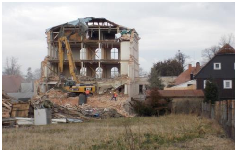
während des Abbruches
