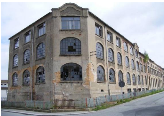
vor dem Abbruch
