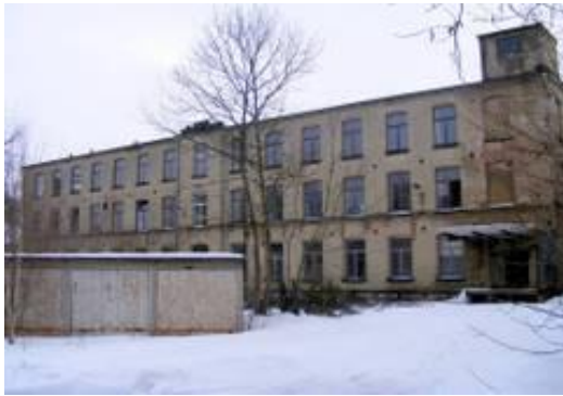
Produktionsgebäude R.-Breitscheid-Str. 35 a vor dem Abbruch
