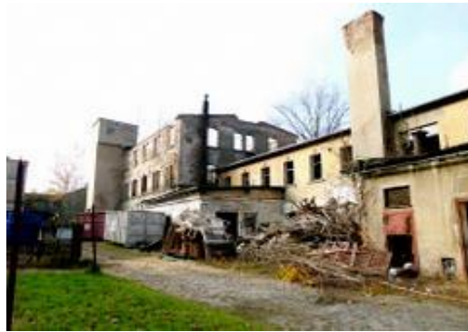
Abbruchbeginn R.-Breitscheid-Straße 37 a
