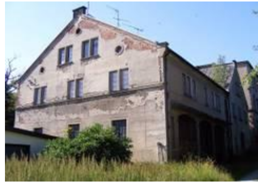
Wohn-u. Garagengebäude R.-Breitscheid-Str. 35 a vor dem Abbruch
