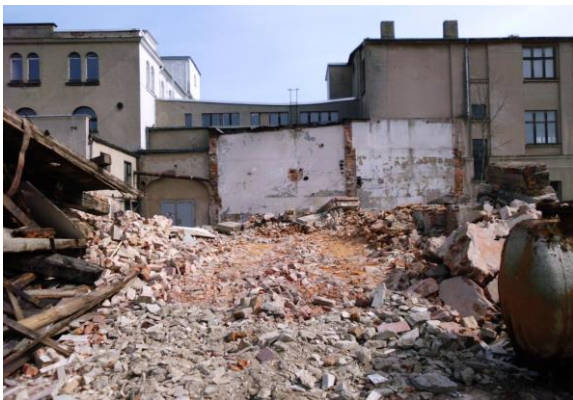
während des Abbruches
