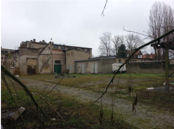
vor dem Abbruch
