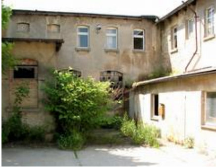
vor dem Abbruch – Verbindungsbau
