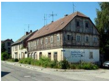
vor dem Abbruch – Büro und Fabrikgebäude E.-Thälmann-Str. 16
