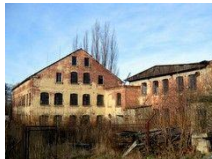
vor dem Abbruch – südlich gelegenes Fabrikgebäude E.-Thälmann-Str. 16 a
