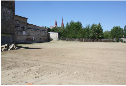
nach Abbruch – im Hintergrund wird die Basilika Maria- Hilf in Filipov wieder sichtbar
