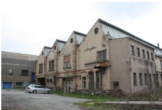
Shedgebäude vor Abbruch
