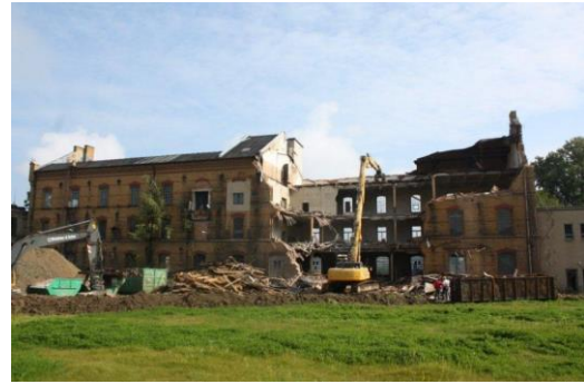
Klinkerbau während des Abbruches
