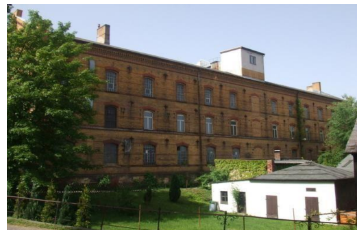
Klinkerbau vor Abbruch
