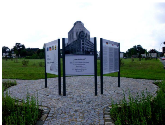
nach dem Abbruch
