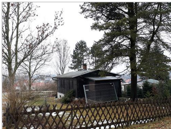
Abb. 4: Blick von Südost
