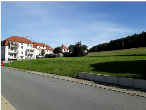
Abb. 5: ehem. bebauten Flächen im Nordteil des Plangebiet
