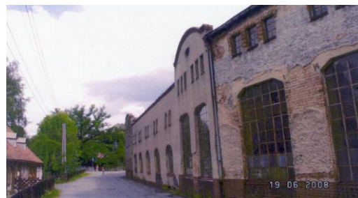
vor Abbruch Seite Mühlstraße
