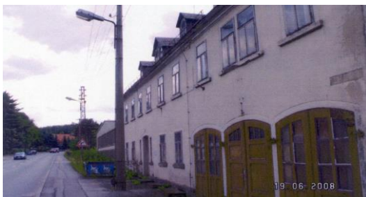
vor Abbruch Seite B 96
