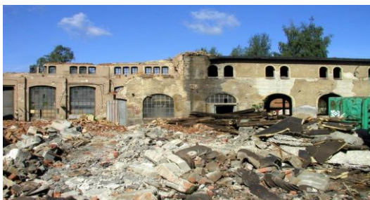
während des Abbruches
