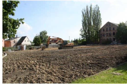
nach dem Abbruch
