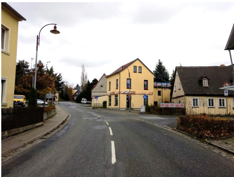
Foto: B 96 im Einmündungsbereich des Unteren Kirchweges (11/ 2017)
