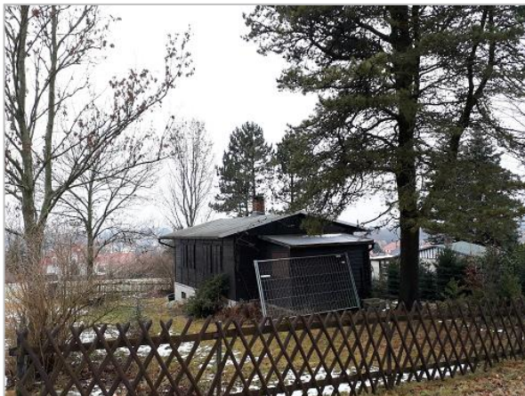
Abb. 4: Blick von Südost
