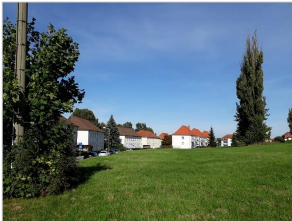
Abb. 3: ehem. bebaute Flächen im Südteil des Plangebietes
