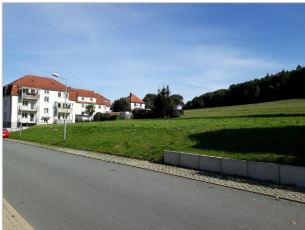
Abb. 5: ehem. bebaute Flächen im Nordteil des Plangebiet
