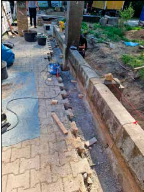
Sanierung Natursteinmauer Fichte-GS
