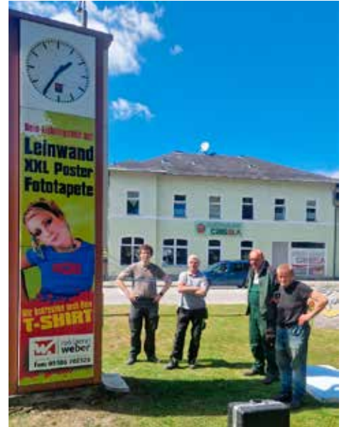
die Uhr an der Neugersdorfer Postkreuzung wurde repariert, Fotos: Bauamt
